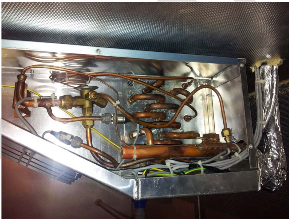
Figura 2.6 Răcitor de aer cu vaporizare directă și ventil de laminare
