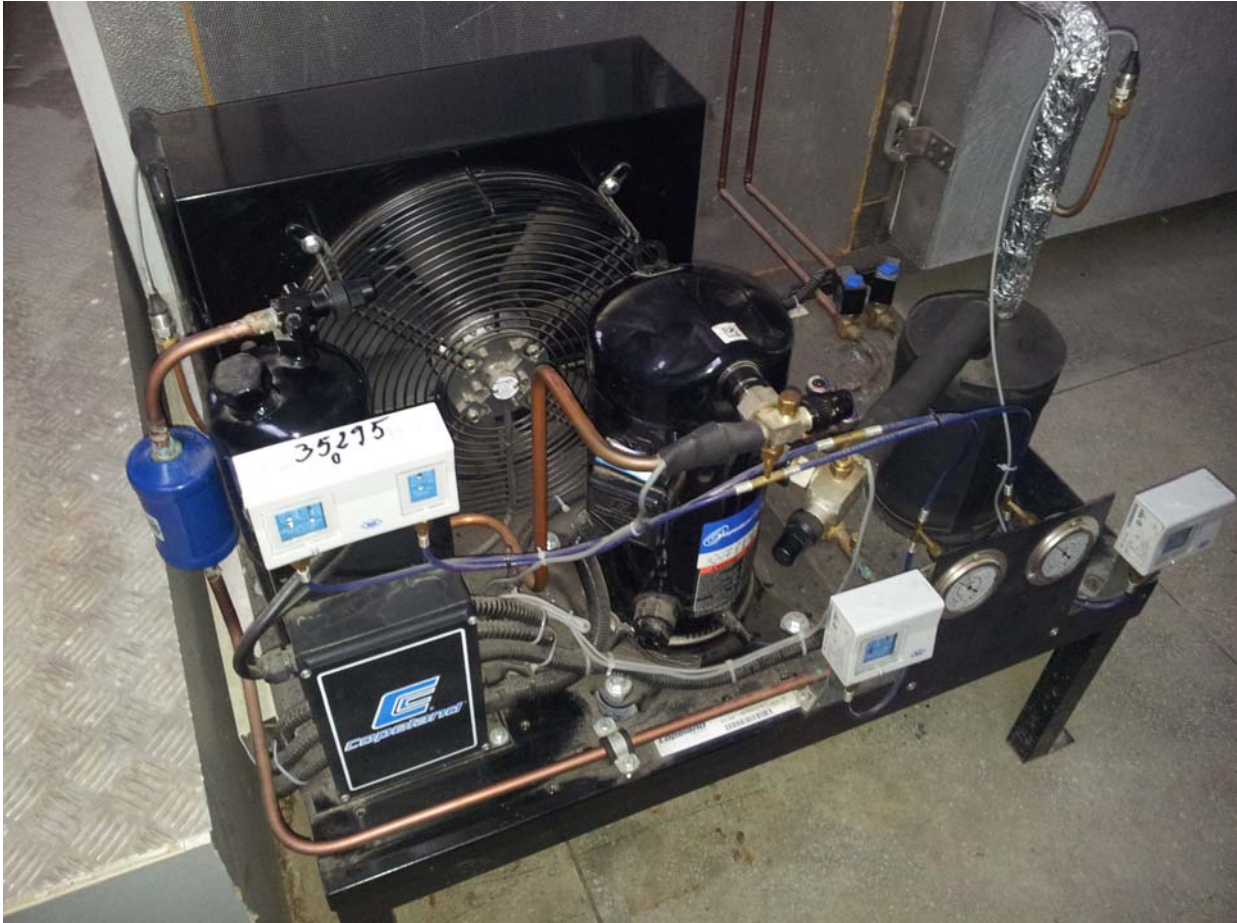
Figura 2.3 Grup compresor-condensator
