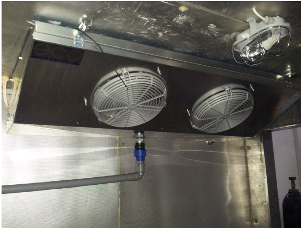
Figura 2.5 Vaporizator - răcitor de aer cu vaporizare directă
