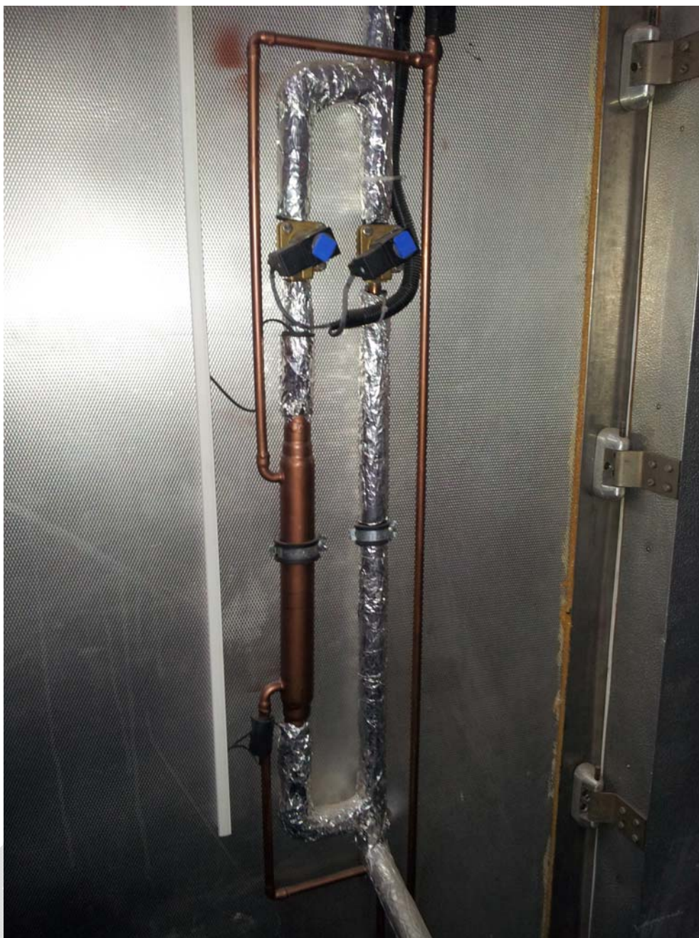
Figura 2.4 Schimbător intern de căldură (regenerativ)
